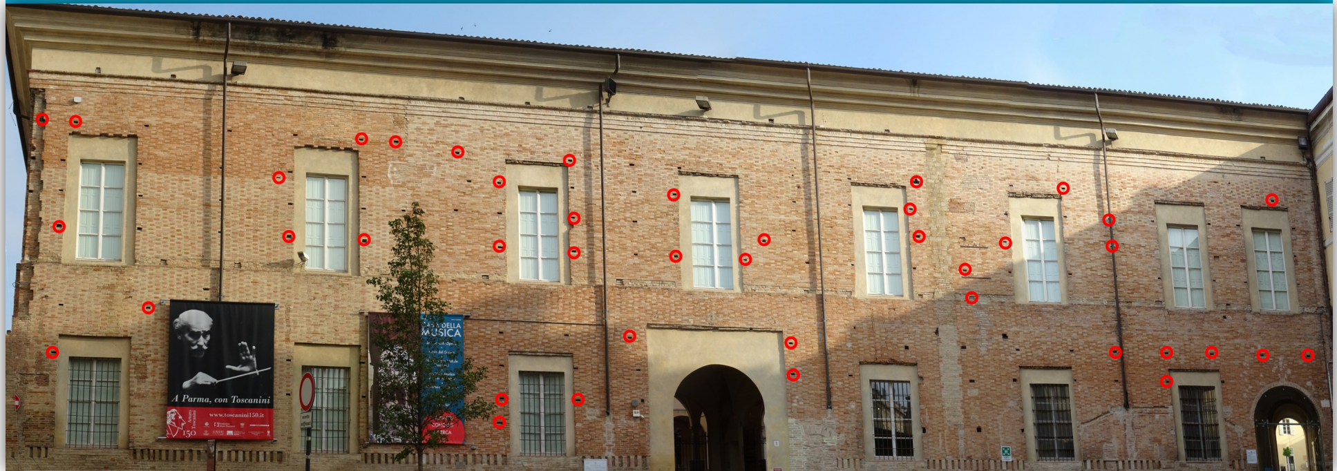
Facciata est - Casa della Musica
